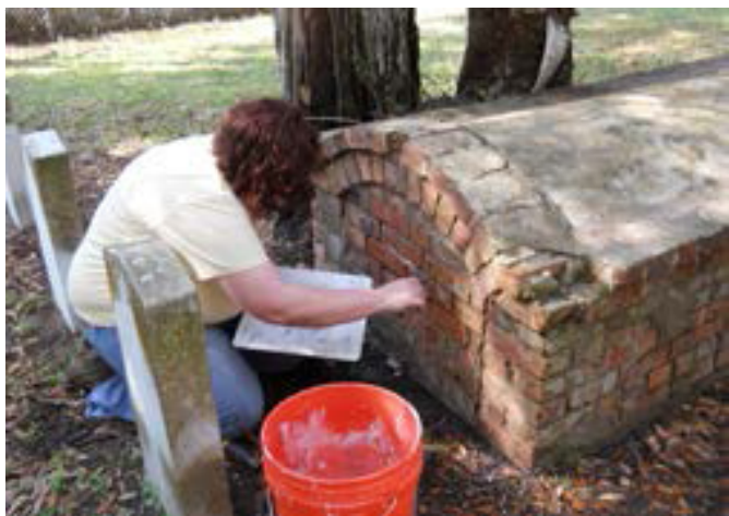
Figura 19. Las lápidas de mampostería como esta tumba de caja pueden requerir el rejuntado de mortero. Es importante utilizar un mortero más suave que el ladrillo histórico. En este caso, un Conservador utiliza un mortero a base de masilla de cal para volver rellenar. Foto: Jason Church.
