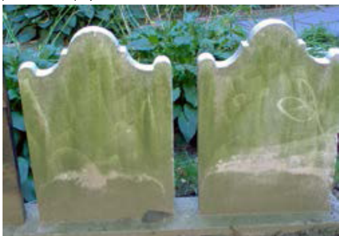
Figura 14. El lavado con agua a alta presión puede dañar las lápidas en tumbas. La fotografía muestra “marcas” en las lápidas producidas por un lavado a presión inadecuado. Foto: Jason Church.
