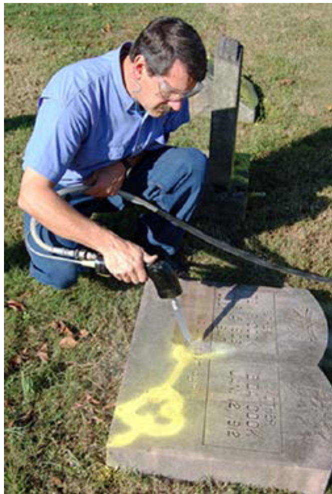
Figura 18. Los grafitis se eliminan cuidadosamente con un instrumento de rociado de baja presión con hielo seco. Foto: Jason Church.
