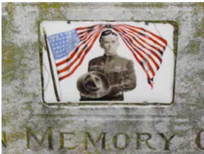
Figura 8. Esta teja de cerámica cocida está colocada en una lápida de mármol, ubicada en el Cementerio de Elmwood, Memphis, TN. Los diferentes materiales pueden requerir distintos enfoques de conservación. Foto: Mary Striegel.
