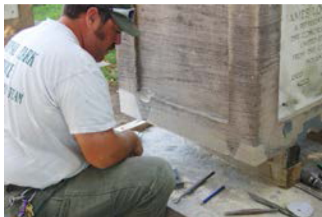
Figura 16. Un albañil profesional trabaja para insertar una nueva pieza de piedra. A menudo denominado “holandés”, esta técnica de reparación requiere reemplazar la sección de piedra deteriorada con una nueva pieza acabada del mismo tamaño y material. Foto: Jason Church.
