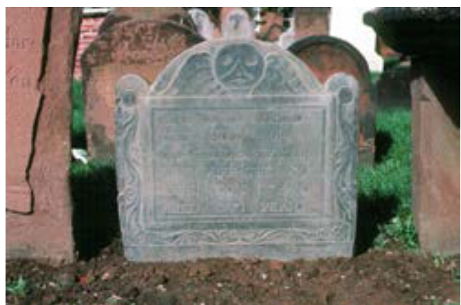
Figura 20c. La lápida de tumba restaurada apoyada en el suelo debe estar nivelada y derecha. Foto: Fran Gale.
