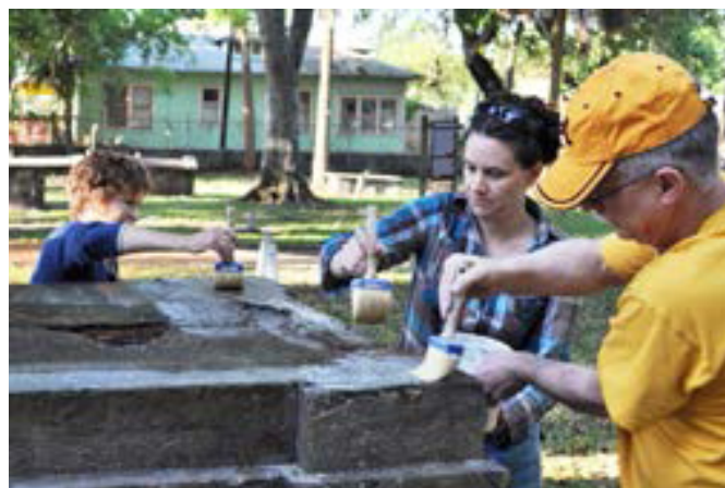
Figura 23. Los encalados de cal y agua es un revestimiento transpirable que a veces se usa para proteger la superficie de las lápidas en tumbas y proporcionan un acabado decorativo. Los encalados de cal y agua se aplican con brocha en cinco a ocho capas delgadas (cada capa tiene la consistencia de la leche descremada). Se deja que la superficie se seque lentamente entre capas. A veces, la superficie se cubre con tela de saco húmeda para disminuir el proceso de secado/fraguado. Foto: Sarah Jackson.
