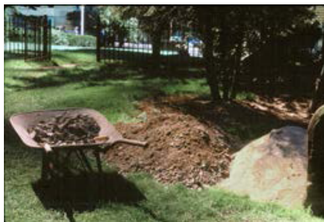
Figura 20b. Para facilitar el drenaje, la piedra triturada, la grava y la arena afilada cubren el orificio y se apisonan a mano alrededor de la piedra después de la colocación. Foto: Fran Gale.
