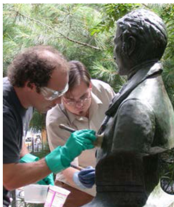
Figura 22. Se debe mantener una capa protectora sobre los elementos metálicos. Los recubrimientos de cera o laca ayudan a preservar la pátina de bronce y retardan la corrosión. Los conservadores aplican una cera microcristalina a este busto en la Iglesia de San Marcos en-the-Bowery, Nueva York, NY. Foto: John Scott.
