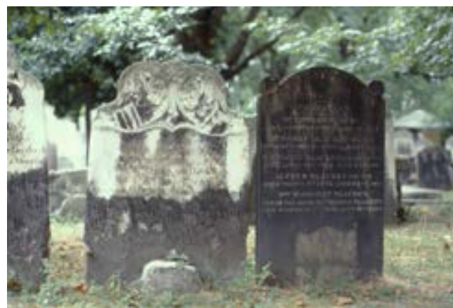
Figura 9. Las lápidas piedra caliza y arenisca en este cementerio histórico tienen diferentes procesos de deterioro. A la izquierda, la piedra caliza muestra una pérdida de superficie en las áreas expuestas al agua de lluvia y la formación de costras de yeso debajo. La lápida de piedra arenisca de la derecha muestra una suciedad uniforme, pero es posible que se esté endureciendo la superficie. Foto: Fran Gale.
