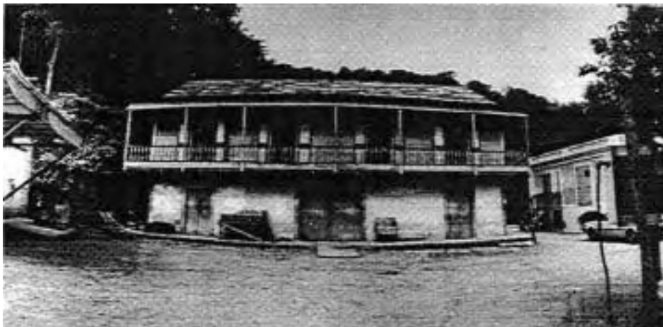
Hacienda Buena Vista Main House before restoration. Ponce, PR (1986).
