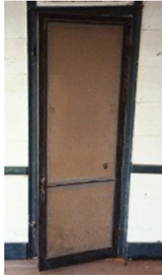
Door 1, Exterior Screen Door
