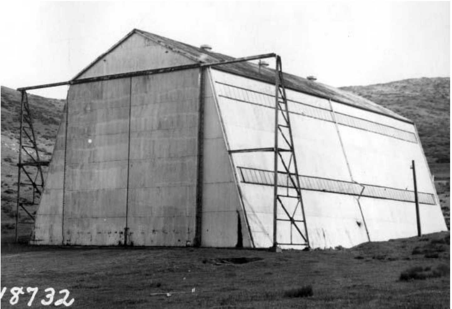
Fort Barry Balloon Hangar, 1939. (PARC, GOGA 32423)
