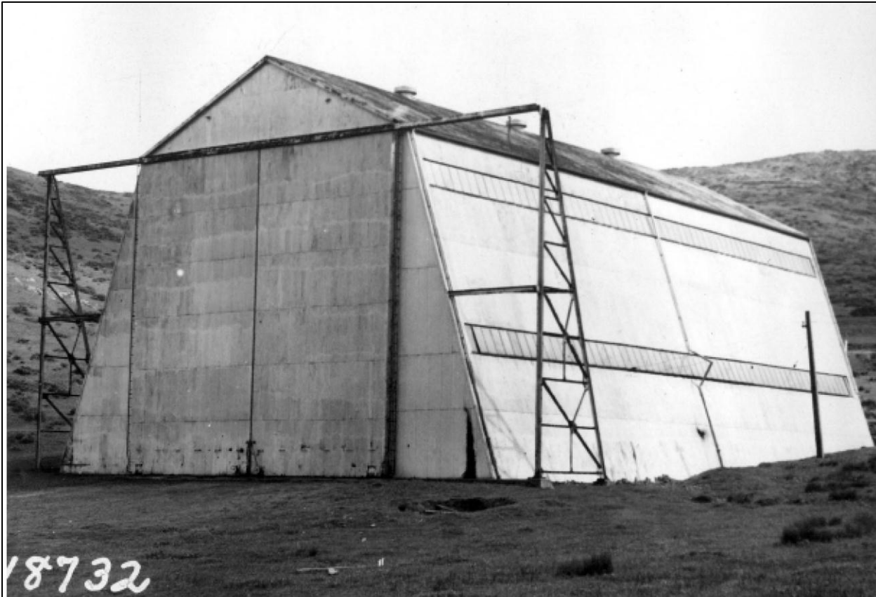
Fort Barry Balloon Hangar, 1939. (PARC, GOGA 32423)
