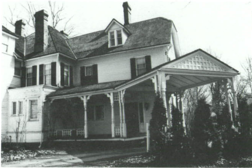
CP-31, West porch (porte cochere).
