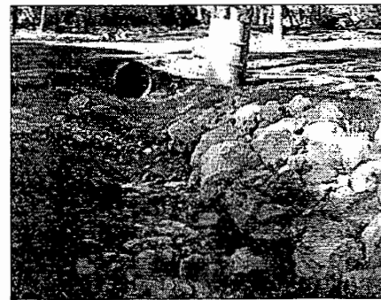
Stone riprap protection
