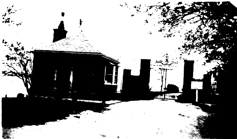
A.P.V.A. Toll House
