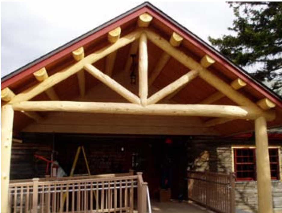
New entryway for Schooner Commons at SERC.
